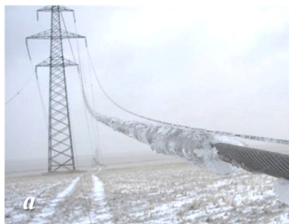
Рисунок 2 а,б Характерное обледенение проводов с круглой проволокой
